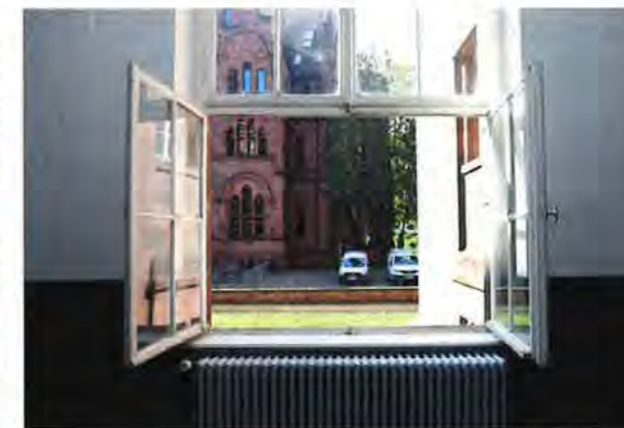
Die alten Fenster wurden ausgetauscht und durch Elemente in der originalgetreuen Gliederung und Ansicht ersetzt.
